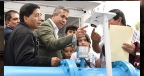
Perforan y rehabilitan nuevos pozos en Ecatepec
