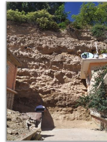
Foto 16 Cara del talud en la calle de Eucalipto
