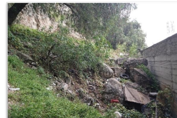
Foto 26 Caídos de rocas en las bardas de las casas.
