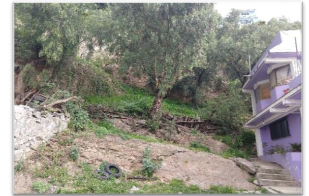
Foto 25 Vegetación en parte del cuerpo del talud.
