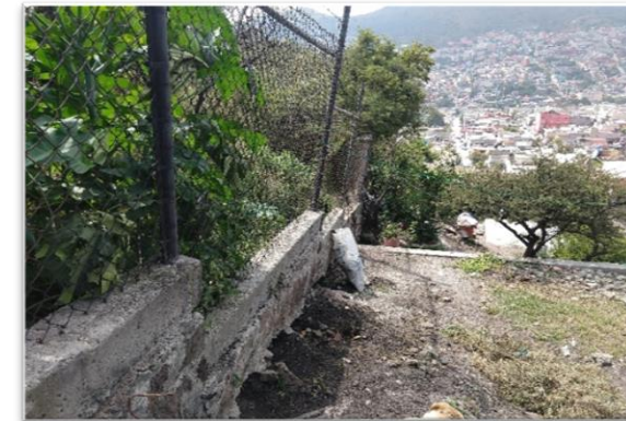
Foto 32 Barda desplazada por las condiciones de caída de rocas y flujos en la zona.
