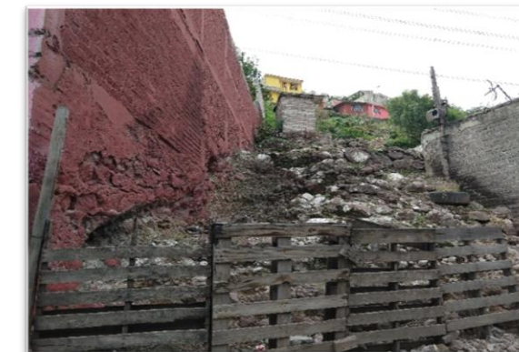
Foto 29 Cimentación de casas en zonas de antiguos flujos de roca.
