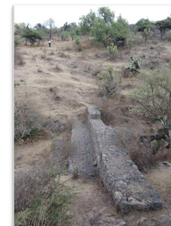
Foto 21 Presa gaviones colocadas a lo largo de la cañada.
