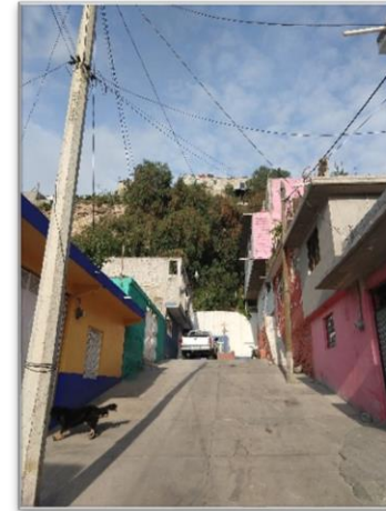
Foto 15 Vista en dirección Poniente del talud Texalpa con un muro de contención al fondo.
