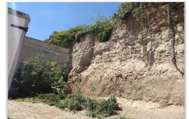
Foto 19 Construcciones en contacto directo con la cara del talud.
