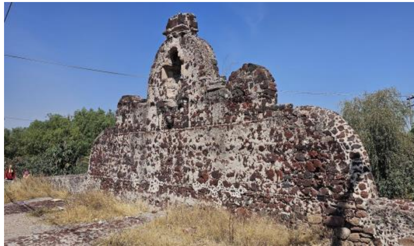
Fuente: Archivo de la Dirección de Obras Públicas del H. Ayuntamiento de Ecatepec de Morelos (2025-2027), Puente de los Virreyes "Albarradón de San Cristóbal".
