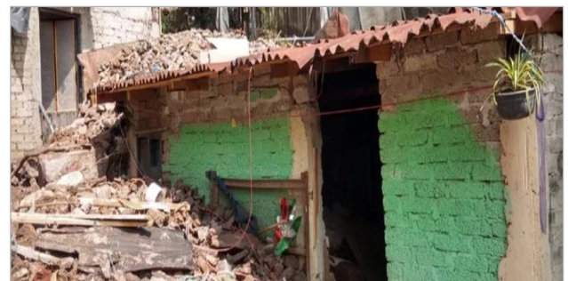
IMAGEN: DESLAVE DE TALUD SOBRE VIVIENDA EN MUNICIPIO DE ECATEPEC DE MORELOS, FUENTE DE LA IMAGEN H. C. BOMBEROS ECATEPEC
