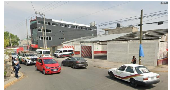
IMAGEN: ESTACIÓN DE CARBURACIÓN SIMULADA EN PROYECCIÓN DE DAÑOS, VISIBLE EN LA IMAGEN PARADA DE TRANSPORTE PÚBLICO (A LA IZQUIERDA), INFRAESTRUCTURA DE TELEFONÍA Y SUMINISTRO ELÉCTRICO.
