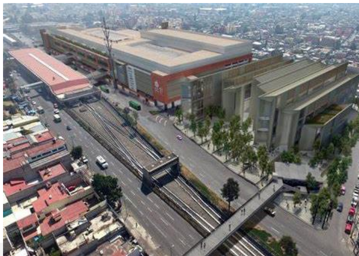
IMAGEN: DE LA ESTACIÓN DE TRANSFERENCIA MULTIMODAL (ETRAM), OBTENIDA DE GOOGLE.
